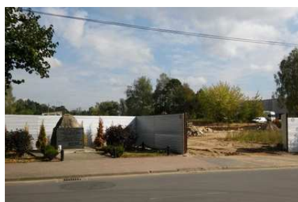
W miejscu fabryki ma stanąć kolejny market.
