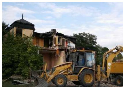
Rozbórka zabytkowego domu Jersaka.
